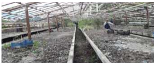
Sera 7 și sera înmulțitor înaintea executării lucrărilor de defrișare, decopertare
