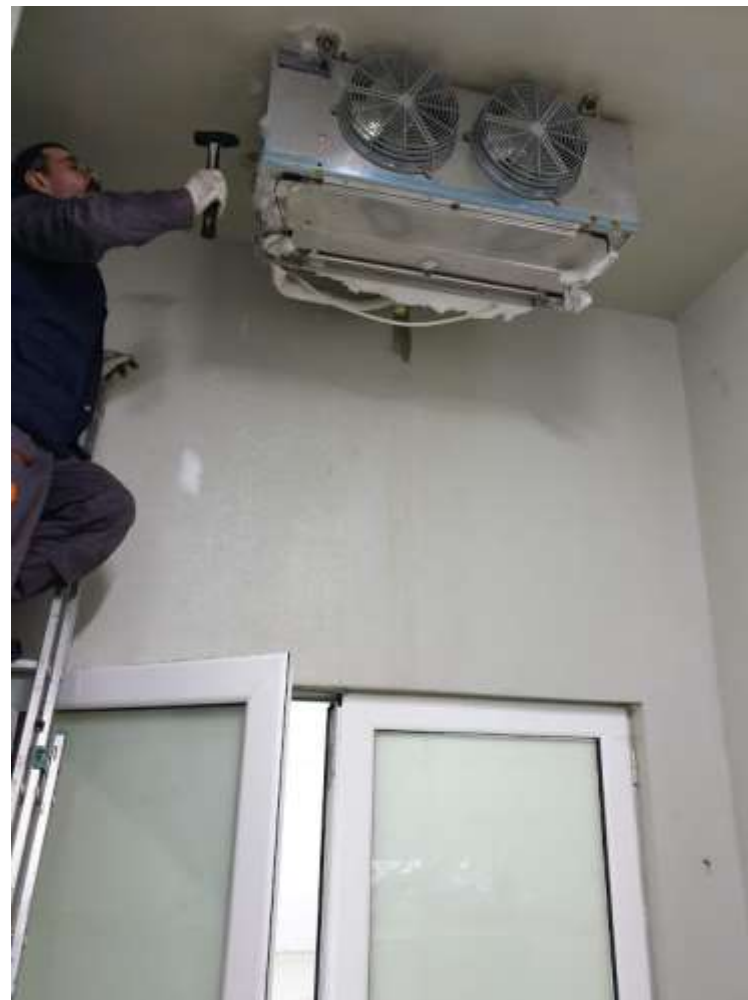
Reparatii agregat răcire – Stație Pilot - Vin
