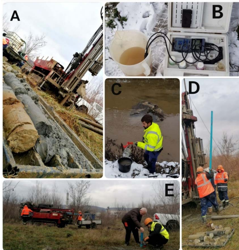
Figura 1: A. Realizarea profilelor de sol cu ajutorul echipamentului ROLATEC RL46L. B. Determinarea pH-ului apei la locul de prelevare C. Prelevarea probelor de apă din albia râului Someș, D. Montarea tuburilor pentru prelevarea probelor de apă la nivelul profilelor de sol. E. Prelevarea probelor de apă la nivelul forajelor realizate pentru probele de sol.
