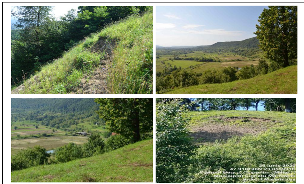
Fig. 6.41. Alunecare de teren monitorizată, Locația 2, Strada Câmpul Negru, , Sighetu Marmației (Sursa: Autorul)
